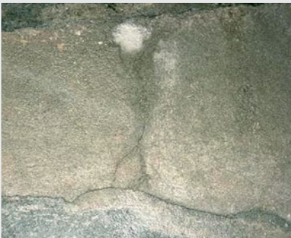
Vyplnené miesta v poteroch , napr. v prípade vybúrania priečok alebo okolo dverí. Je tu veľké riziko vzniku trhlín v miestach napojenia. Bežne je nutné toto napojenie riešiť dodatočne pomocou „zošívania“ so živcami.
