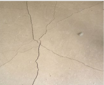
Popraskané potery , u ktorých je „zošívanie“ trhlín so živcami veľmi ťažko riešiteľné a náročné.
