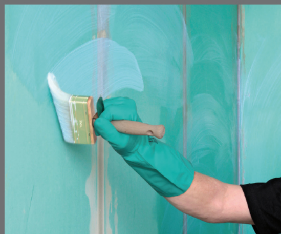
PCI Gisogrund® PGM – penetrácia podkladu
