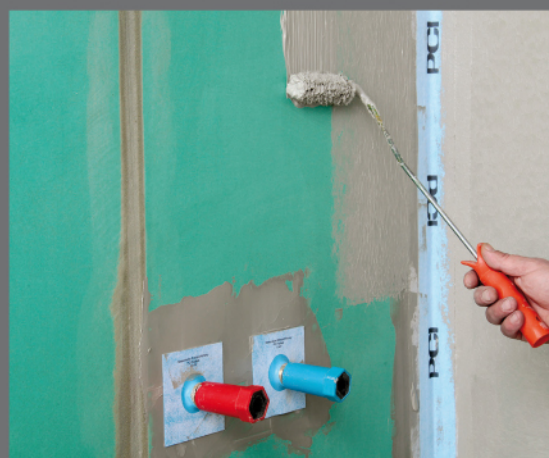
PCI Pecitape® 10x10 – izolácia prestupov PCI Pecitape® Objekt – izolácia kútov
