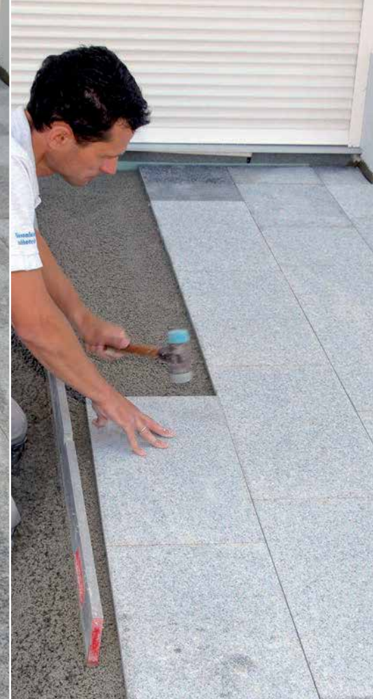
Na takto pripravený podklad sa kladie dlažba metódou čerstvý do čerstvého s pokladacou maltou PCI Carrament
