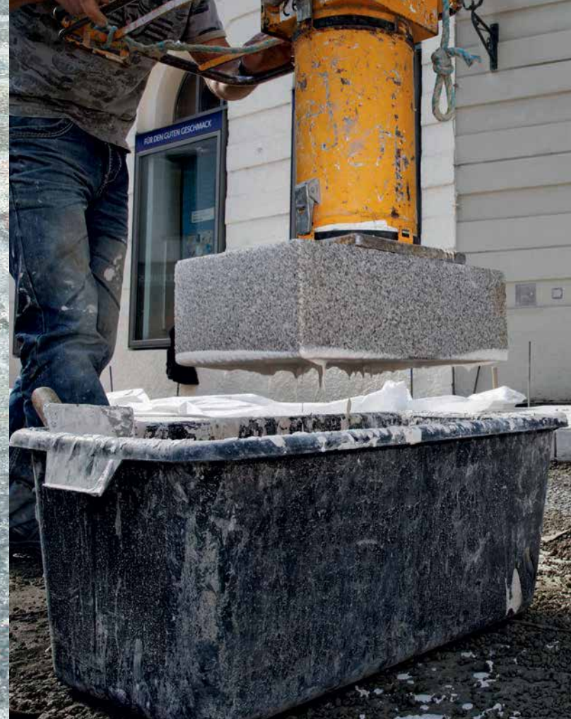
PCI Carrament ako pokladacia malta na pokládku metódou čerstvý do čerstvého.
