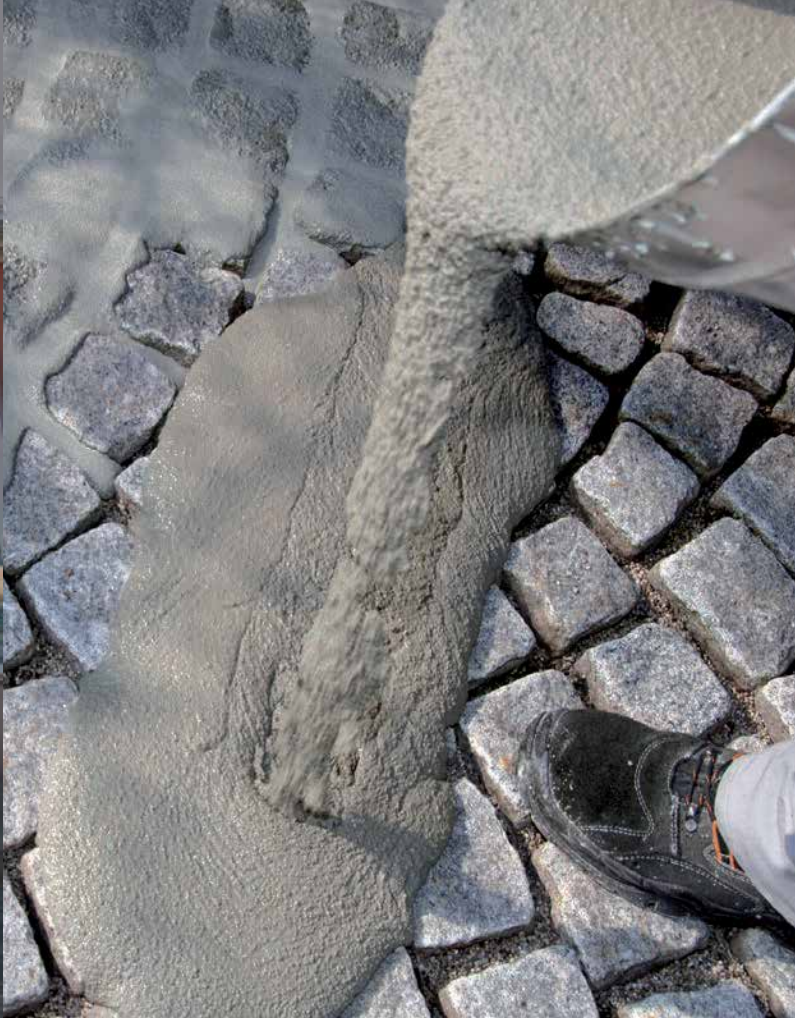
PCI Pavifix CEM rozmiešajte na homogénnu zmes a aplikujte do škár. Plochu opláchnite jemným prúdom vody.
