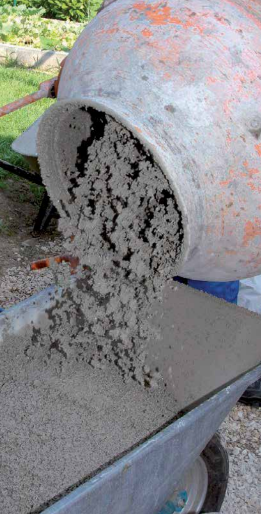
PCI Pavifix DM miešajte s vodou do vytvorenia homogénnej zmesi.
