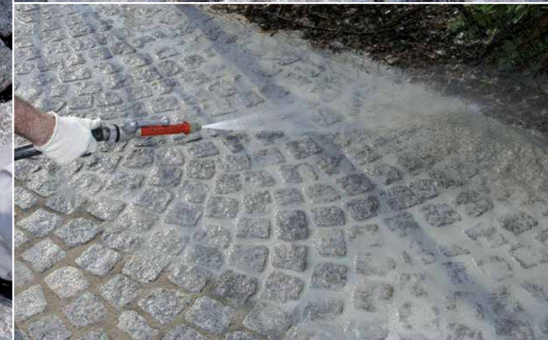
PCI Pavifix CEM rozmiešajte na homogénnu zmes a aplikujte do škár. Plochu opláchnite jemným prúdom vody.
