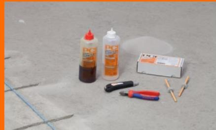
PCI Apogel SH a PCI Apogel Dübel sú ideálnou kombináciou na spojenie dilatácií plávajúcich poterov. Aplikáciou dokážu zabrániť vertikálnemu pohybu medzi doskami.
