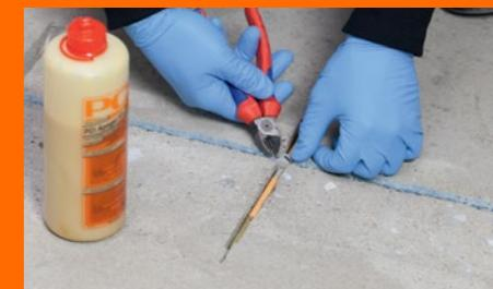
Do rezov kolmých na dilatačnú škáru sa vložia klzné trny PCI Apogel Dübel, ktoré sa zafixujú pomocou silikátovej živice PCI Apogel SH.
