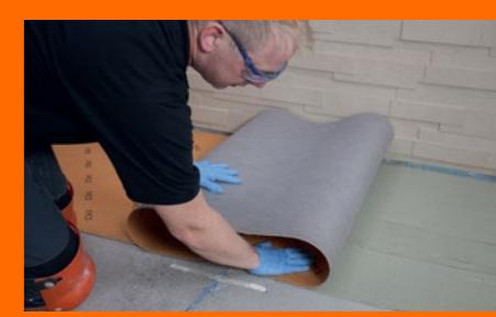
Po približne 40 min sa nalepí izolačný a oddelovací pás PCI Pecilastic U do lepidla PCI Flexmörtel S2.
