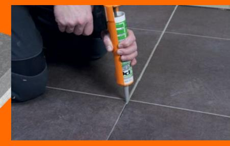
Na škárovanie je ideálne použiť škárovaciu hmotu PCI Nanofug Premium, najbližšiu škáru k dilatácii vyplňte rovnakým odtieňom pružného silikónového tmelu PCI Silcofug E.
