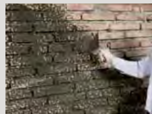
Nanášení stříkané omítky zušlechťené pomocí PCI Emulsion.
