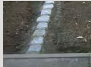
Pokládání dlažebních kostek, obrubníků a lemování záhonů pomocí PCI Pavifix® USM.
