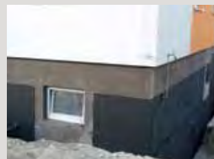
Přechod z černé izolace na PCI Seccoral® 2K Rapid přes vrchní hranu terénu.
