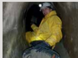
Aplikace těsnicí hmoty sulfátovzdorné PCI Saniment® DS/PCI Barraseal® v oblasti odpadních vod.
