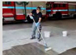
Základní nátěr připravované plochy epoxidovou pryskyřicí, jako je např. PCI Apogrund®.
