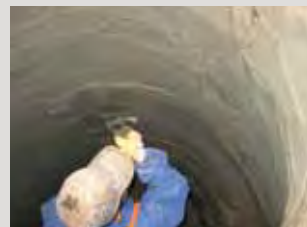
Zhotovení podkladu s rovným povrchem pomocí produktu PCI Nanocret® R4.
