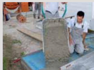
Aplikace jednosložkové malty PCI Pavifix® DM na podpůrnou drenážní podložku.
