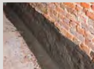
Těsnění sklepa ve vnitřním prostoru minerální těsnicí hmotou PCI Barraseal®.
