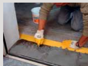
Vyrovnání prahu nebo schodu trvanlivou maltou na bázi epoxidové pryskyřice PCI Aposan®.
