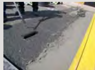
Aplikace maltového adhezního můstku pomocí PCI Pecihaft®.
