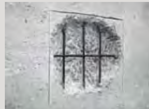
Odstranění rzi a starých nátěrů z výztuže.
