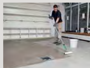
Cca po 1 dni lze cementové hmoty na vyrovnávání podlah finálně upravit např. uzavíracím nátěrem PCI Zemtec® Top.
