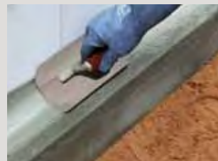
Ostré hrany se vytvoří jako fabion pomocí opravné malty PCI Nanocret®/PCI Polyfix®.
