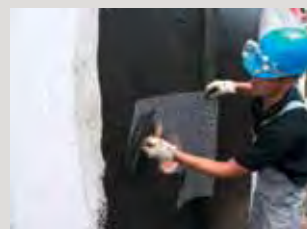
Vložení pásu tkaniny PCI do míst s trubními prostupy.
