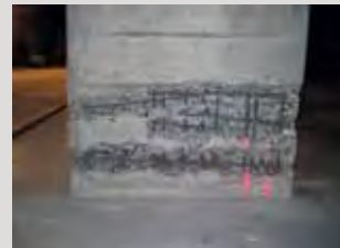
Odstranění betonu poškozeného chloridy v garáži.
