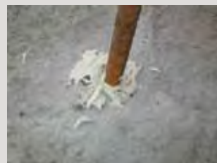
Vyplnění vyvrtaných děr cementovým přípravkem PCI Verguss-Fix.
