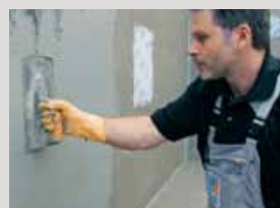
Aplikace rychle vytvrzující těsnicí hmoty PCI Seccoral® 2K Rapid na překlenutí trhlin, odolné proti UV záření, ve vodní nádrži.
