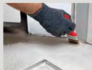
Ruční nanášení matujícího uzavíracího nátěru PCI Zemtec® Top.
