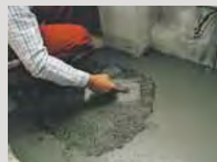
Nanášení stříkané omítky zušlechťené pomocí PCI Emulsion.
