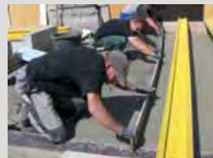
PCI Peciment® 50 na můstku dle ZTV-Ing.
