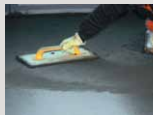
Případně je třeba pod dělicí vrstvu nanést vyrovnávací spojovací potěr.
