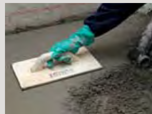
Rychle tvrdnoucí potěr PCI Novoment® je třeba nanést na čerstvý spojovací můstek (čerstvý do čerstvého).
