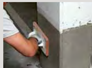
Aplikace jemné stěrky PCI Nanocret® FC.
