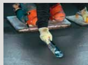
Potěry na povrchu uhladit hladítkem nebo hladíčkou.
