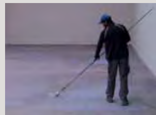
Před použitím tekutého samonivelačního potěru nanést PCI Gisogrund® 404 jako pojivo.
