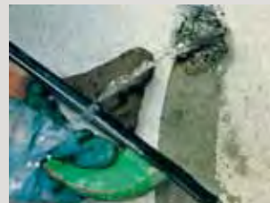
PCI Polyfix® 30 sek. použitý jako blesková cementová malta pro rychlé utěsnění vyhloubenin způsobených vodou.
