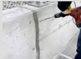
Stavební dílec se navrtá ve směru šikmo k trhlíně, střídavě vpravo a vlevo. Vytvrtný otvor musí přetínat trhlínu zhruba uprostřed.
