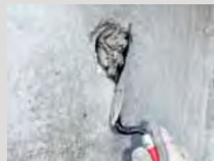
Uzavření dutin pomocí PCI Polyfix® 5 min nebo PCI Repafix®.
