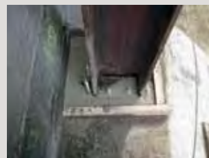
Zálivka podpěry pomocí PCI Repaflow®.
