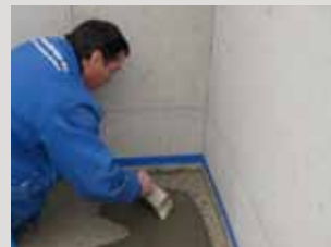
U spojovacích potěrů je třeba nanést spojovací můstek z PCI Repahaft®.
