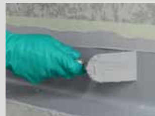
Těsnicí pásek PCI Pecitape® 3000 se důkladně přitlačí a uhladí se hladítkem.
