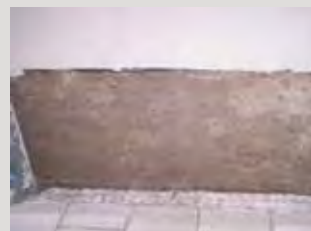
Strojní aplikace těsnicí omítky ve vnitřním prostoru sklepa a na soklu fasády.
