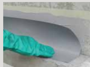
Stavební lepidlo na bázi epoxidové pryskyřice PCI Barrafix® EP se rovnoměrně nanese a vloží se těsnicí pásek.
