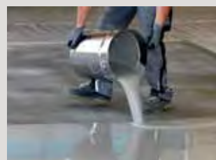
Nanášení roztíratelné vrstvy.
