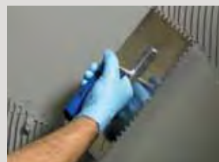
Aplikace pružné těsnicí hmoty pro překlenutí trhlin PCI Seccoral® 2K Rapid.
