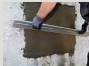
Opravené plochy se naráz stáhnou a po krátké čekací době se uhladí.
