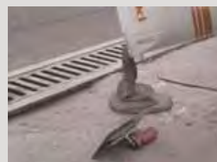
Vyrovnání betonové podlahové plochy pomocí malty s tekutou konzistencí PCI Repafast® Fluid.
