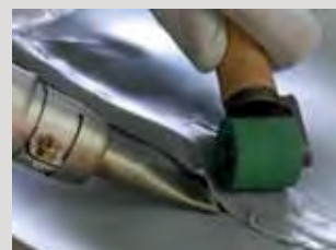
Svaření těsnicích pásek a lepení rohových spojů se provádí horkovzdušnou pistolí. Je nutno zajistit roztažnost.
