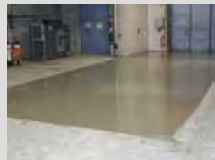
Vyrovnaní betonové podlahy lehce roztíratelným, tekutým potěrem PCI Zemtec® 180.
