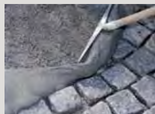
Nanášení cementové spárovací malty PCI Pavifix® CEM na předem navlhčené dlažební kostky.
