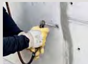
Injektážní pakr se pevně zašroubuje do předem vyčištěného vyvrtaného otvoru.
