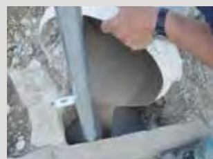
Upevnění vestavných dílů pomocí PCI Verguss-Fix.
