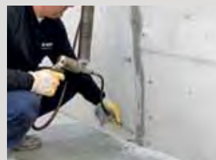
Injektážní pryskyřice se injektuje zdola nahoru až do úplného zaplnění.
