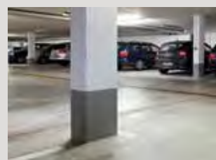
Sloup opravený pomocí jemné stěrky PCI Nanocret® FC.
