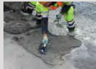
Trvanlivé vyrovnání vylomení v betonové podlaže pomocí PCI Repafast® Tixo.
