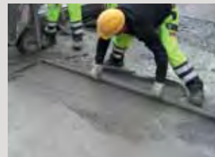
Trvanlivé vyrovnání podlahové plochy betonu pomocí PCI Repafast® Tixo.
