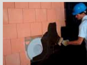
Utěsnění lze provést v jedné vrstvě nebo ve 2 vrstvách v závislosti na každém jednotlivém případě aplikace.
