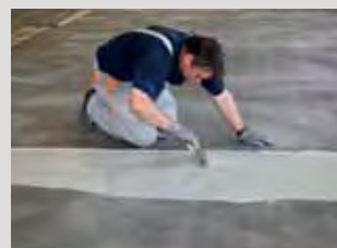
Ruční nanášení na dilatační spáru.
