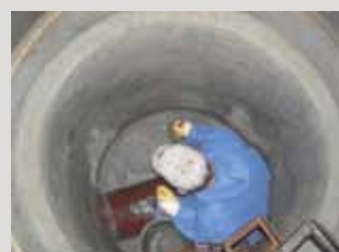
Spárování a osazování skruže produktem PCI Polyfix® Plus L.
