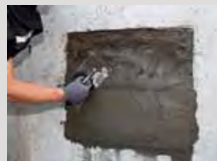
Vysokopevnostní opravná malta, např. PCI Nanocret® R4 se nanáší ruční nebo strojní aplikací, v hutné vrstvě bez pórů.
