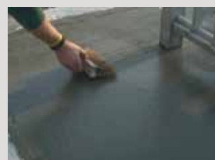
Roztírání koštětem na PCI Peciment® 50.
