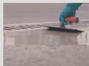
Aplikace záливkové malty na bázi epoxidové pryskyřice PCI Repaflow® EP Plus u žlabu.
