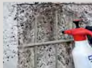
Před prováděním sanace betonu se plochy navlhčí, aby byly matně vlhké, popř. se na ně nanese základní nátěr PCI Nanocret® AP.
