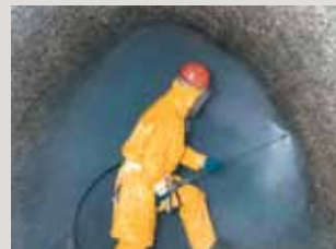
Příprava poškozeného betonového povrchu v kanálu.
