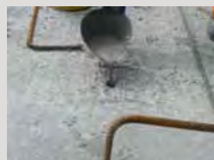
Vyplnění vyvrtaných děr cementovým přípravkem PCI Verguss-Fix.
