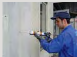
Vyplnění a fixace/ukotvení pomocí chemické kotvy PCI Barrafix® 920.
