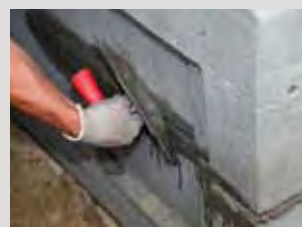
Těsnění spár, vyrovnání rohů a hran pomocí PCI Nanocret® R2.
