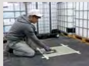
PCI Peciment® 50 ve výrobní hale pro skladování a plnění chemických produktů.
