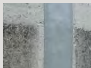
Utěsnění dvou prefabrikovaných dílců pomocí PCI Pecitape®.
