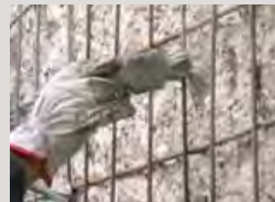
Antikorozi nátěr armovací oceli aktivní ochranou výztuže PCI Nanocret® AP.
