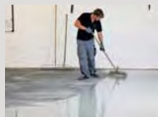
Rozetření stěrkou (raklí) a jehlovým válečkem.
