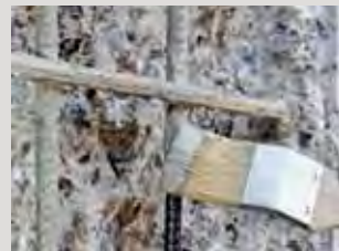
Aktivní ochrana výztuže PCI Nanocret® AP se nanáší celoplošně minimálně ve 2 vrstvách.
