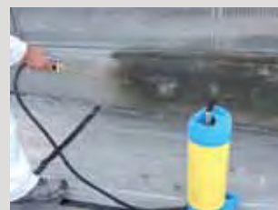
Ruční aplikace produktu PCI Silconal® – transparentní, jako hydrofobní ochrana a ochrana proti znečištění nevytvářející film.
