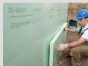
PCI Pecimor® DK se aplikuje celoplošně na izolační desku, která se přilepí. Bodové lepení je přípustné také v oblasti nad hladinou podzemní vody. Styky jednotlivých desek s produktem Pecimor® DK se zatrou stěrkou.
