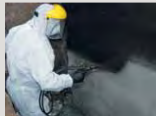
Ochranný nátěr savého podkladu pomocí PCI Pecimor® F.
