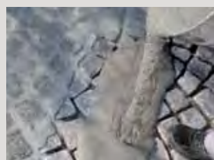
Nanášení drenážní spárovací malty PCI Pavifix® 1K Extra na předem navlhčené dlaždice z přírodního kamene.
