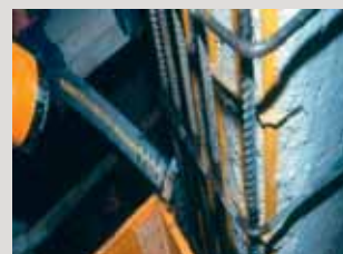
Aplikace vysokopevnostní malty s tekutou konzistencí PCI Nanocret® R4 Fluid v oblasti s těsným uspořádáním výztuže.
