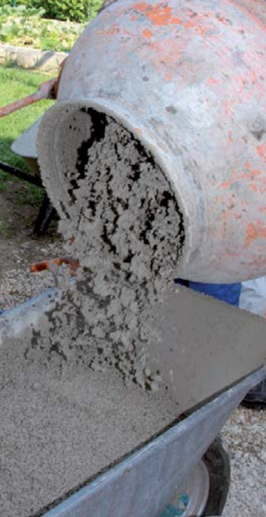
PCI Pavifix® DM miešajte s vodou do vytvorenia homogénnej zmesi.
