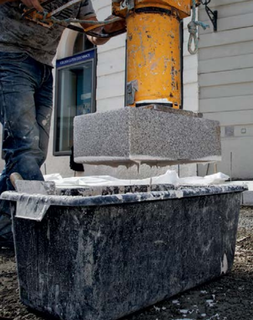
PCI Carraflott® NT ako kontaktný mostík na pokládku metódou čerstvý do čerstvého.
