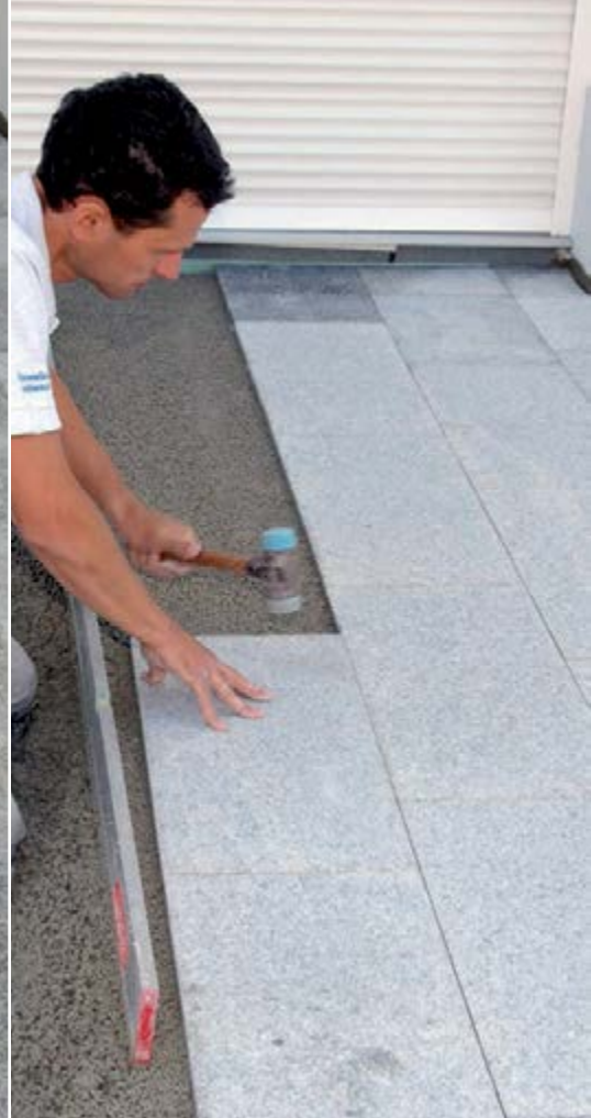
Na takto pripravený podklad sa kladie dlažba metódou čerstvý do čerstvého s kontaktným mostíkom PCI Carraflott® NT.
