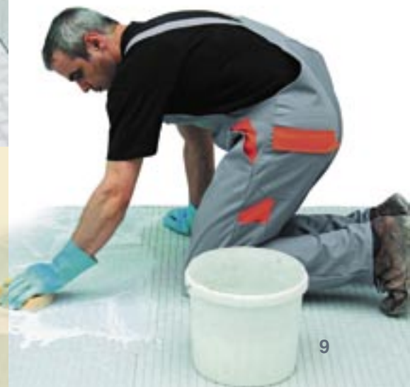
Spárování mozaiky (obkladů) na stěnách a podlaze se provede epoxidovou pryskyřicí PCI Durapox NT nebo NT plus, která je vysoce odolná proti oděru i působení chemikálií. Následné omytí a dočištění spár se udělá horkou vodou. Případný epoxidový zaschlý šlem lze odstranit čisticím PCI Spezial-Reiniger Epoxi.
