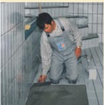
Keramické kameninové obklady se pokládají kombinovaným postupem (Buttering–Floating) do lepidla PCI FT-Klebemörtel s příměsí emulze PCI Lastoflex.
