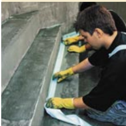
Vložení pásky PCI Pecitape® 120, resp. Pecitape® Objekt do čerstvě nanesené první vrstvy izolace PCI Seccoral®.
