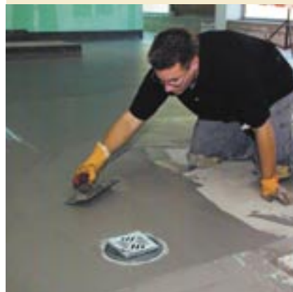
Nanášení první vrstvy stěrkové izolace PCI Seccoral® na vlhký podklad jako záškrab. Po proschnutí je nutné aplikovat dostatečně silnou vrstvu tak, aby po proschnutí byla síla hydroizolace min. 2 mm.
