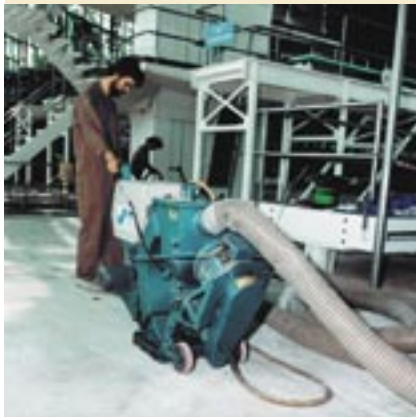
Bezprašná příprava podlahového podkladu strojem Blastrac.
