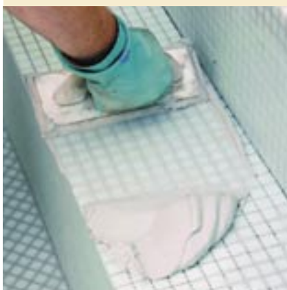
Spárování mozaiky (obkladů) na stěnách a podlaze se provede epoxidovou pryskyřicí PCI Durapox NT nebo NT plus, která je vysoce odolná proti oděru i působení chemikálií. Následné omytí a dočištění spár se udělá horkou vodou. Případný epoxidový zaschlý šlem lze odstranit čisticím PCI Spezial-Reiniger Epoxi.
