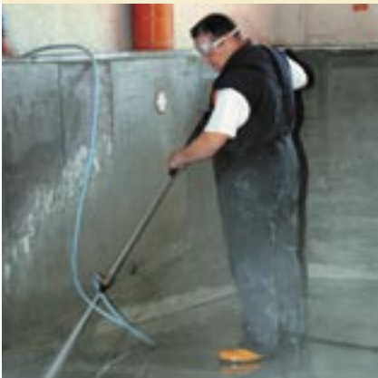
Příprava podkladu betonové konstrukce otrýskáním pískem.
