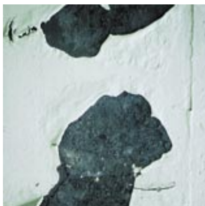
Izolace separovaná od podkladu vlivem osmotického tlaku.
