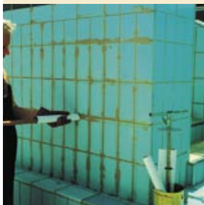
Starší cementové spáry, které jsou poškozeny, lze přespárovat epoxidovou pryskyřicí PCI Durapox® NT (Plus). K tomu stačí minimální hloubka spáry od 3 mm.
