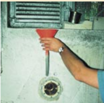
Dodatečné zalití netěsné vtokové trysky pomocí epoxidové pryskyřice PCI Apotén® (přes plexisklo lze kontrolovat kvalitu provedení)
