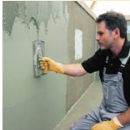
Vyrovňování nerovností podkladů (stěna) 1–5 mm s betonovou stěrkou PCI Polycrret® 5, od 3–100 mm vylehčenou maltou EMACO Nanocrete R2 nebo 3–20 mm s vyrovnávací maltou PCI Pericret®.
