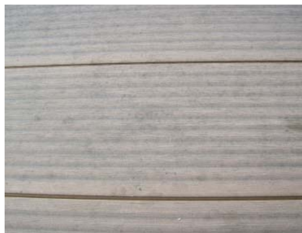
Stav povrchu dlouhodobě neudržované terasy.
