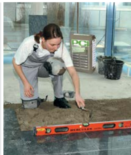
Pokládka do maltového lože
