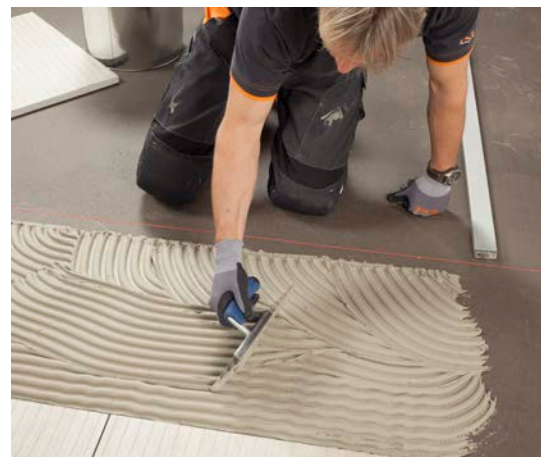
Lepení dlažby do lepidla PCI Flexmörtel® S2 (PCI Nanoflott® light, PCI Pericol® Fluid).
