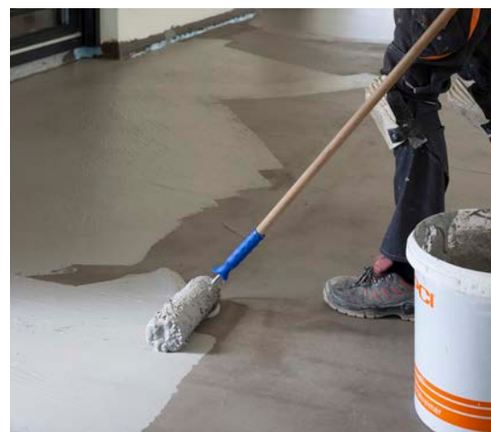
Izolace pomocí PCI Seccoral® 2K Rapid.
