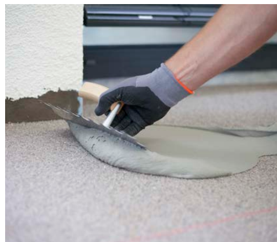
Nejprve před pokládkou dlažby proveďte záškrab.
