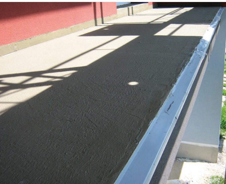
Aplikovaná cementová stierková hydroizolácia PCI Seccoral®
