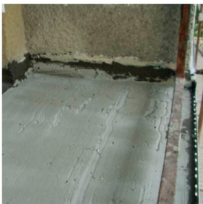
Aplikovaná cementová stierková hydroizolácia PCI Seccoral®
