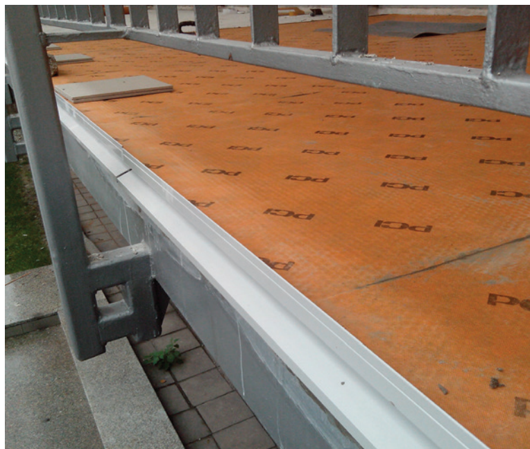
Aplikovaná pásová hydroizolácia PCI Pecilastic® U
